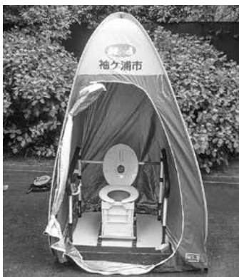
マンホールトイレ設営の様子
